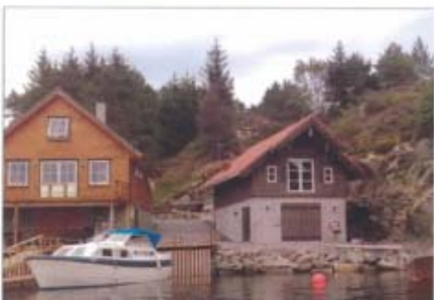
Bilete: Naustet til Gjelsvik (til høgre) manglar kaifront, noko som gjer området dårleg tilrettelagt og framkomeleg
